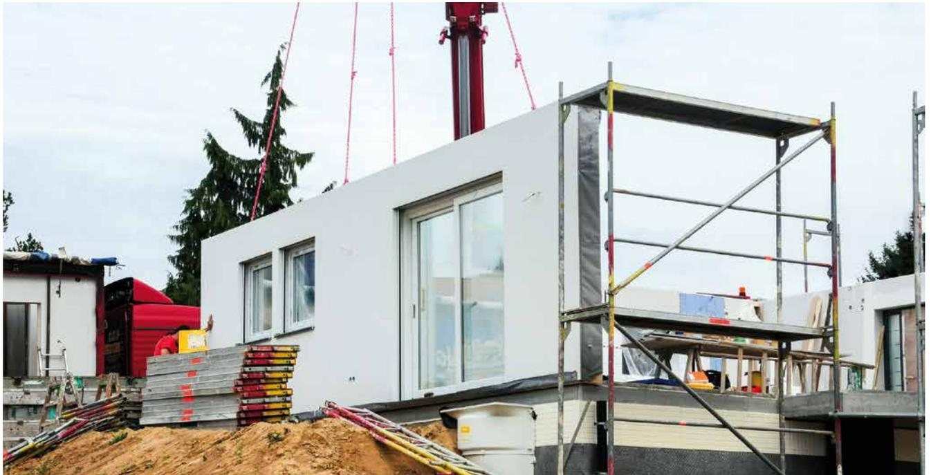
*Trotz der verbreiteten Anwendung der Holzbauweise kann man Fertighäuser auch aus anderen massiven Bauelementen bauen.*
