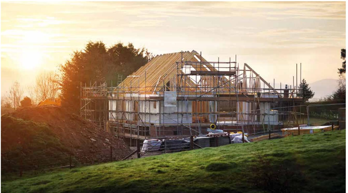
*Häufig bildet eine tragende Konstruktion aus Holz den Kern eines Fertighauses.*
