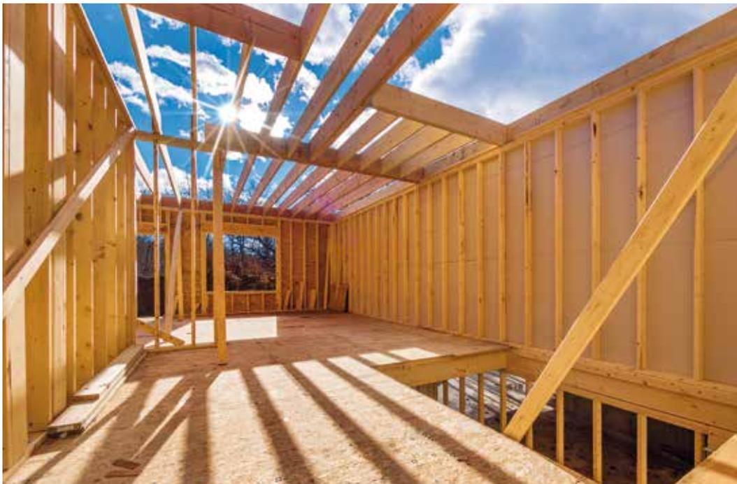
*L'ossature de la plupart des maisons préfabriquées est une structure porteuse en bois.*
